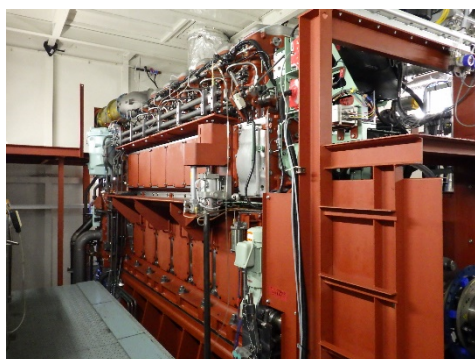
アンモニア燃料エンジン実機
